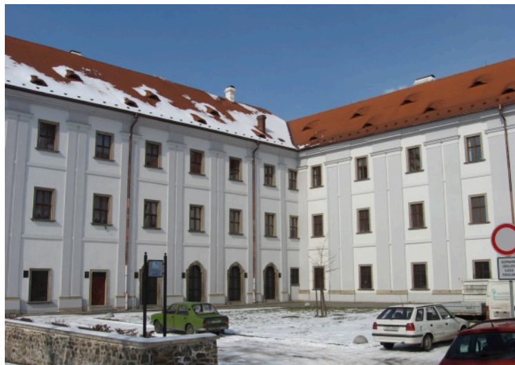
Objekt bývalých kasáren pod Černou věží. foto Rudolf Lang
