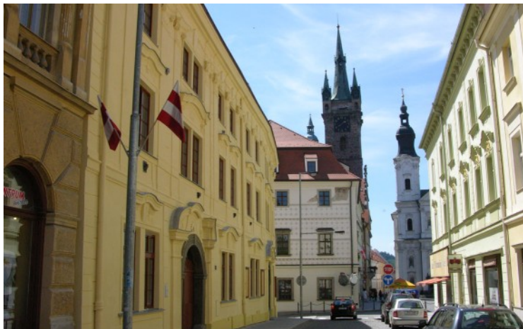
Výsledek opravy fasády objektu čp. 3-4/IV.
