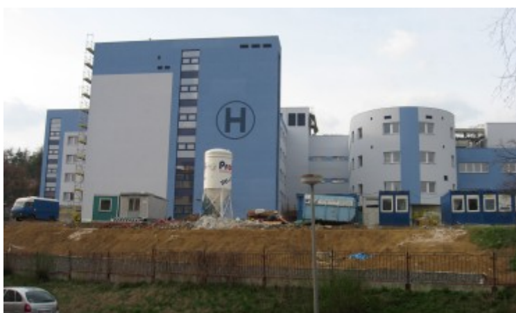
Výstavba nemocnice pokračuje bez jednoho pavilonu.
