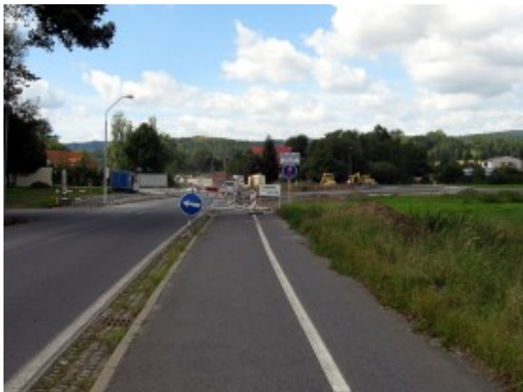
Výstavba mostu a okružní křižovatky. Lokalita u bazénu před Tajanovem.
