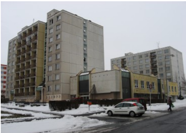
Budovy Domova důchodců a Domu s pečovatelskou službou
