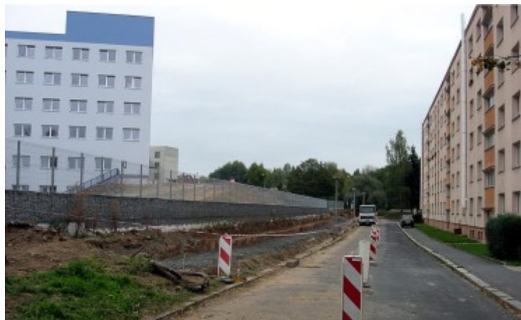
Parkovací stání v ul. Pod nemocnicí
