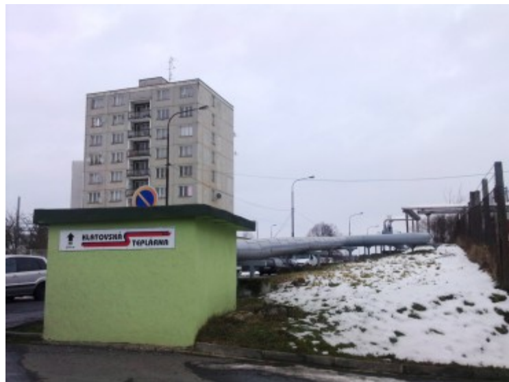
Parovody Klatovské teplárny, a.s.
