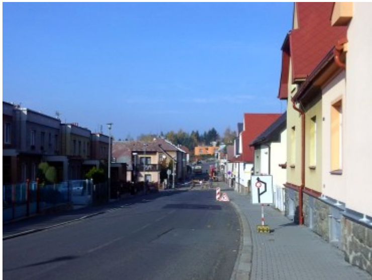
Rekonstrukce kanalizace v Měchurově ulici foto Rudolf Lang
