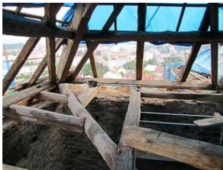
Poškozené patní části krovu
