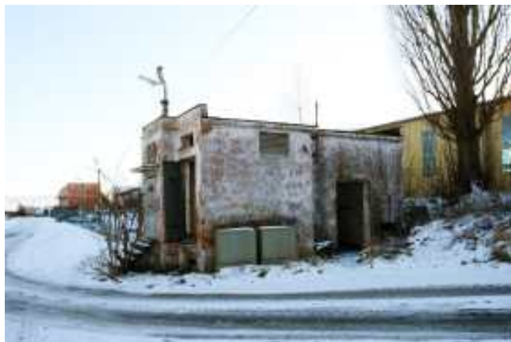
Objekt staré trafostanice v bývalých kasárnách na Plánické ul.
