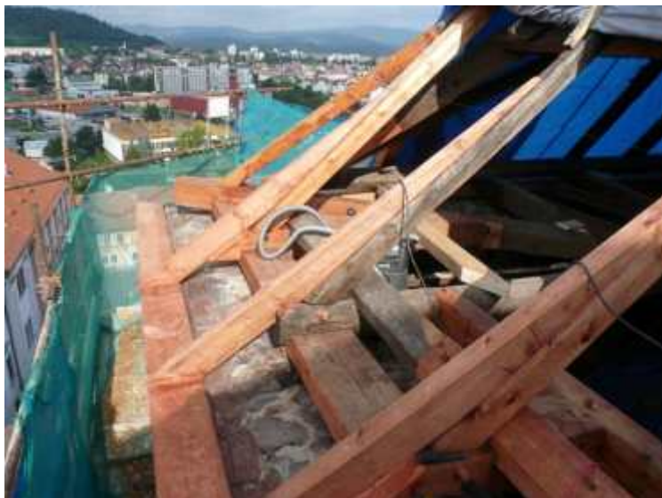
Výměna pozednic a protézování prvků krovu
