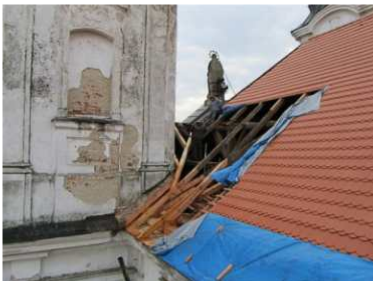
Výměna pozednic a protézování prvků krovu
