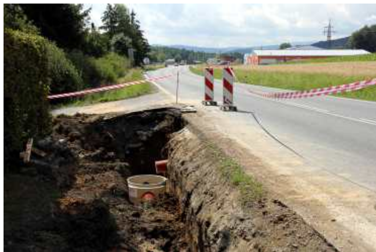
Výstavba chodníku podél silnice I/27 v obci Luby
