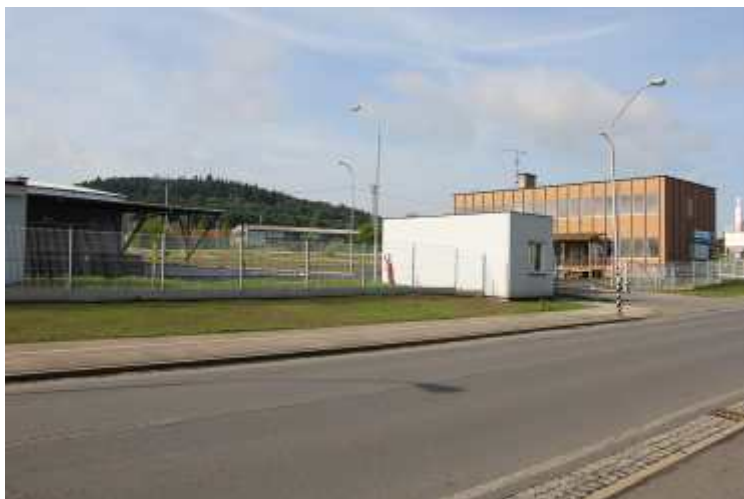
Vjezd do nového areálu z ulice Dr. Sedláka. foto: Rudolf Lang
